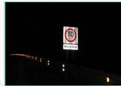
Señalamiento sucio disminuye la reflectividad
