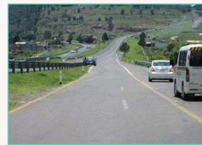
Falta de señal "Ceda el paso" y velocidad
