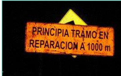
Señalamiento temporal de obra deteriorado
